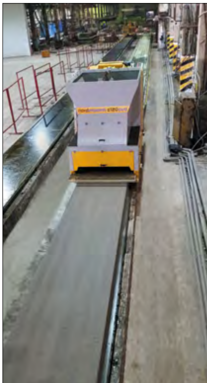
Два производственных станда безопалубочного формования – первый шаг в развитии современной линии по производству преднапряженных изделий на заводе «Сокол»
